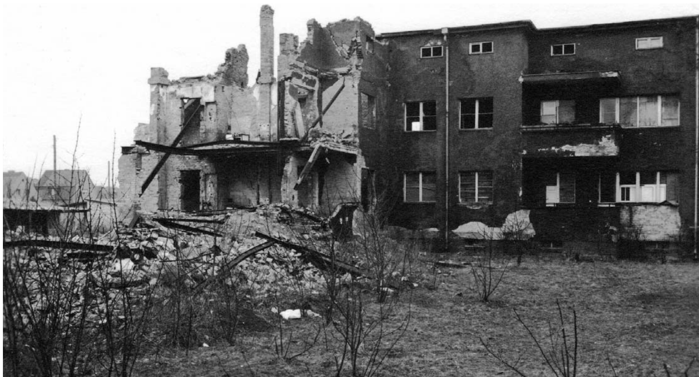
Kriegsschäden am Gebäude Kampweg 6, 6A (Archiv)
