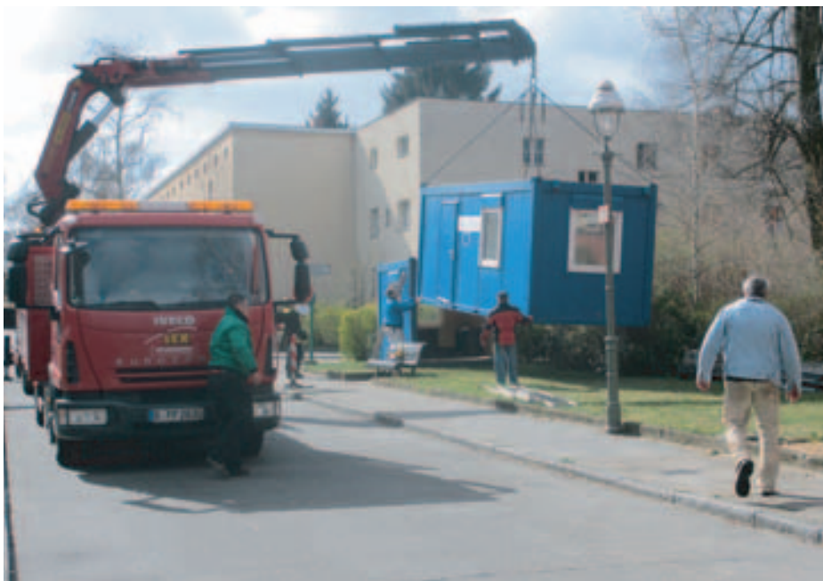
Die Arbeiten auf der diesjährigen Großbaustelle im Allmendeweg begannen pünktlich am 2. April 2012 mit der Aufstellung des ersten Baucontainers.
