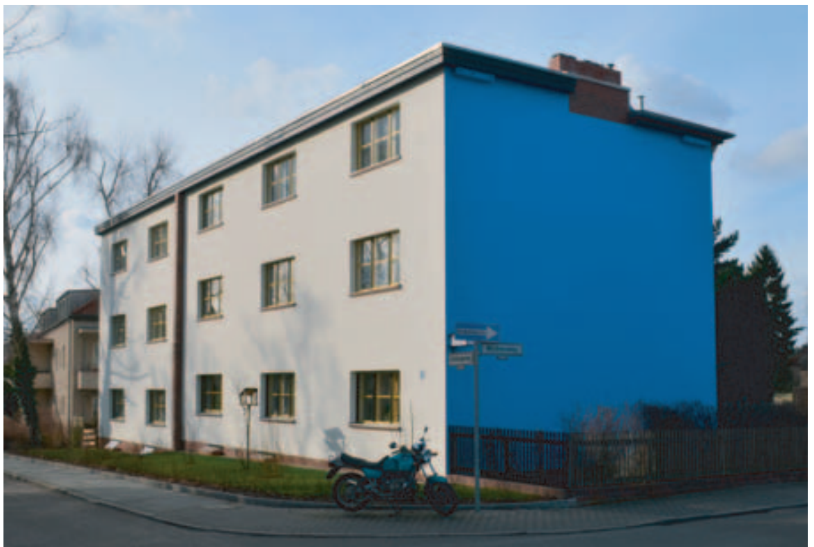
Aufnahme nach der Sanierung vom März 2015.
