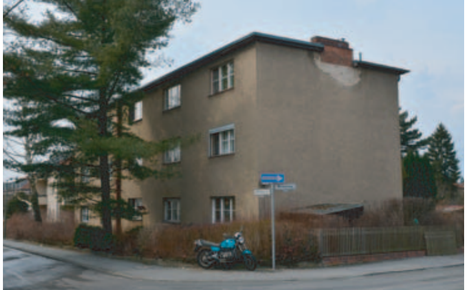
Aufnahme vor der Sanierung des Gebäudes Erholungsweg 40/48.
