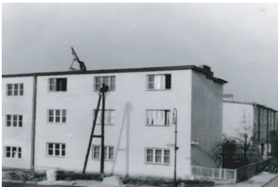
Erholungsweg 40/48 nach dem Beseitigen der Kriegsschäden November 1952.
