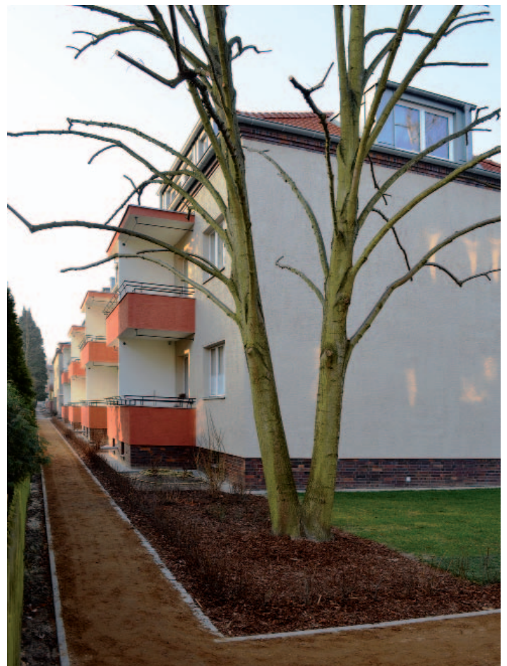
Talsandweg 3/9 nach Fertigstellung im Februar 2016
