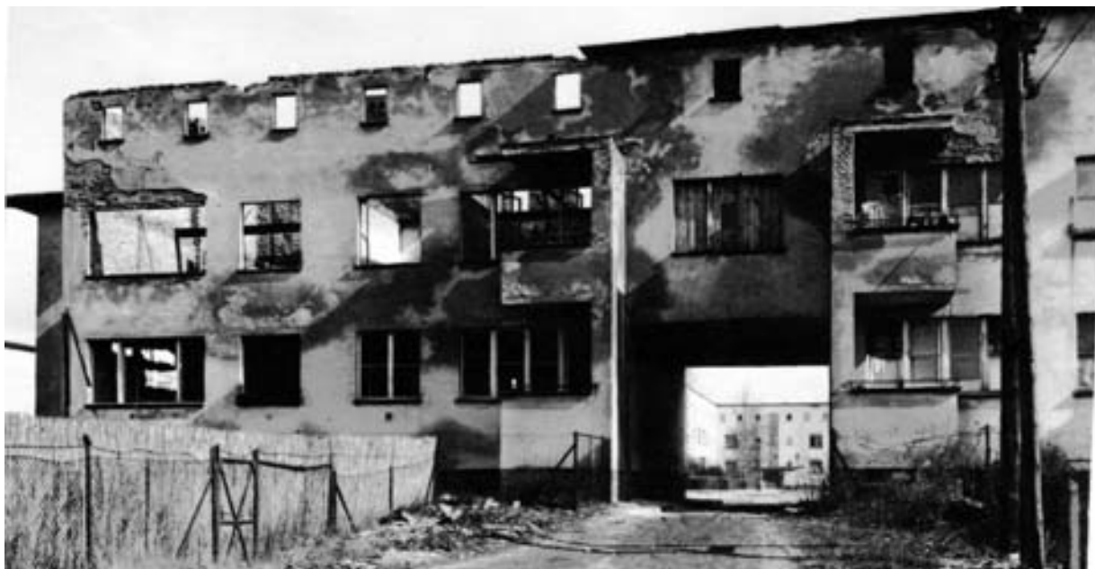
Brandschäden im Schollenhof 15, 16 nach dem Luftangriff am 26.11.1943 (Archiv)
