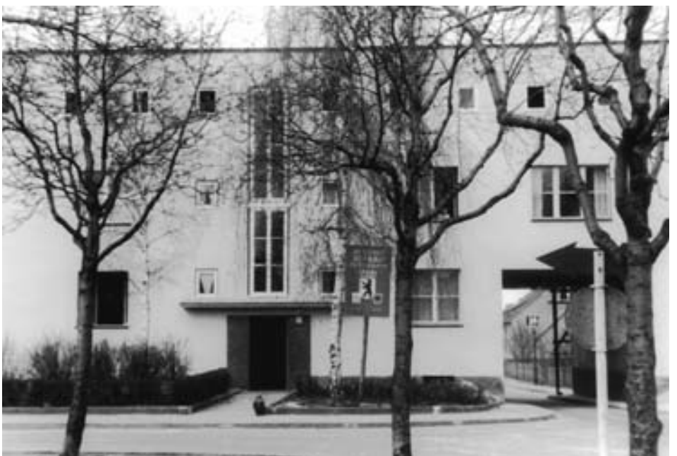
Schollenhof 23 nach der Fassadensanierung; Aufnahme vom Mai 1955 (Archiv)
