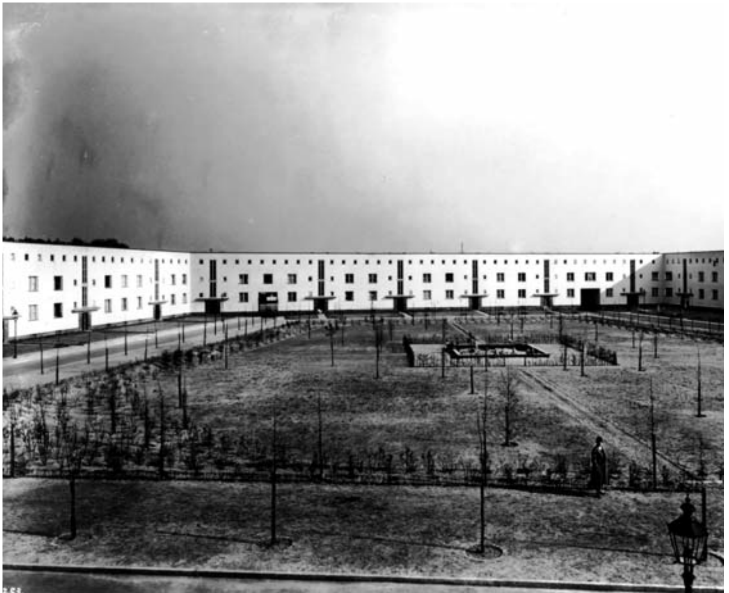
Foto Anfang der 30er Jahre, Blick nach Süden Richtung Waidmannsluster Damm; im linken Bereich ist die durch Büsche markierte abgerundete Form des Hufeisens zu erkennen (Archiv)
