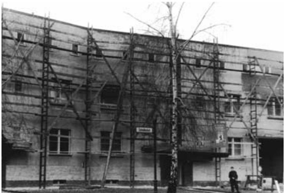
Fassadenarbeiten am Schollenhof 14,15; Aufnahme vom April 1955 (Archiv)
