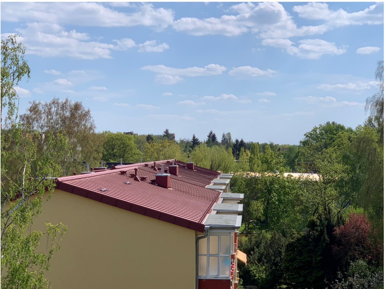
Dachsanierung Rosentreterpromenade 2020 (Foto: Hoeltke)
