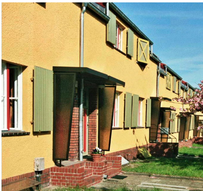
Die Fassaden der Wohnhäuser werden gemäß Denkmalsvorgaben saniert
